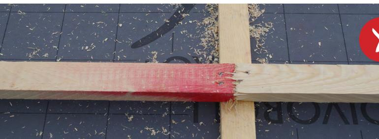
**OHNE TECTUM** - nicht regelwerkkonform, Mit der Zeit trocknet das Holz, zieht sich zusammen und die Lattenköpfe können sich von der Befestigung lösen. Durch Sägen entstehen Sägespäne und somit Reinigungsaufwand.
