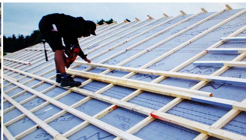
Am Ende der Dachlatte den Verbindner einfach bis zur Hälfte aufschieben.
