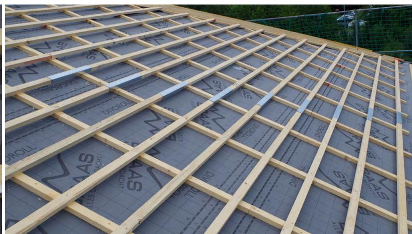
Sollte der Verbindner auf einer Konterlatte liegen, wird er lediglich mit einem Nagel befestigt.
